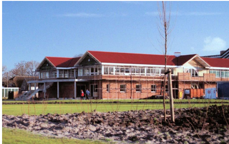
Het clubgebouw in aanbouw
