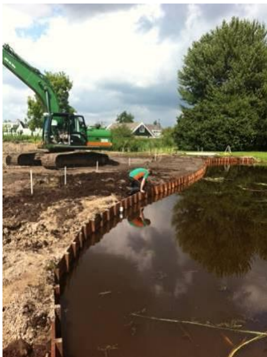
Het aanbrengen van de beschoeiing bij de green van hole 17
